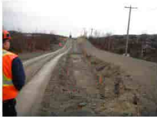
Préparation de la tranchée
