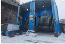
Installation de murs pour contrôler les emportements de poussière lors du déchargement
