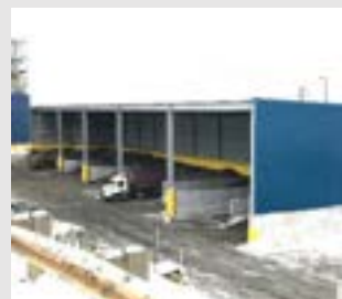
Entrepôt pour concentrés
