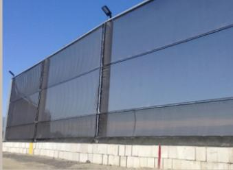
Construction d'une clôture brise-vent de 35" de haut x 850" de long à l'aire de refroidissement de la scorie, pour minimiser les emportements éoliens de poussières (2 M\$).
