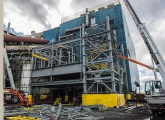
Remplacement de l'unité de traitement des gaz d'opération du Convertisseur Noranda, permettant des gains environnementaux et économiques (15 M\$).
